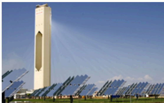
(F) Acumulador térmico: central solar térmica [6].
